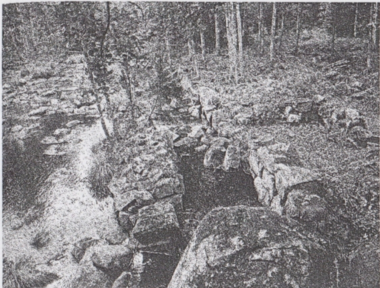
Delar av grunden efter Bråneholms pappersbruk syns i bildens högra del. Parallellt med denna ser man den stensatta rännan, i vilken ett vattenhjul roterade och gav papperstillverkningen den behövliga energin.
